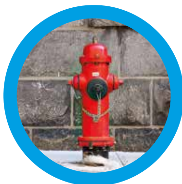
Canalisation eau Line pipe
